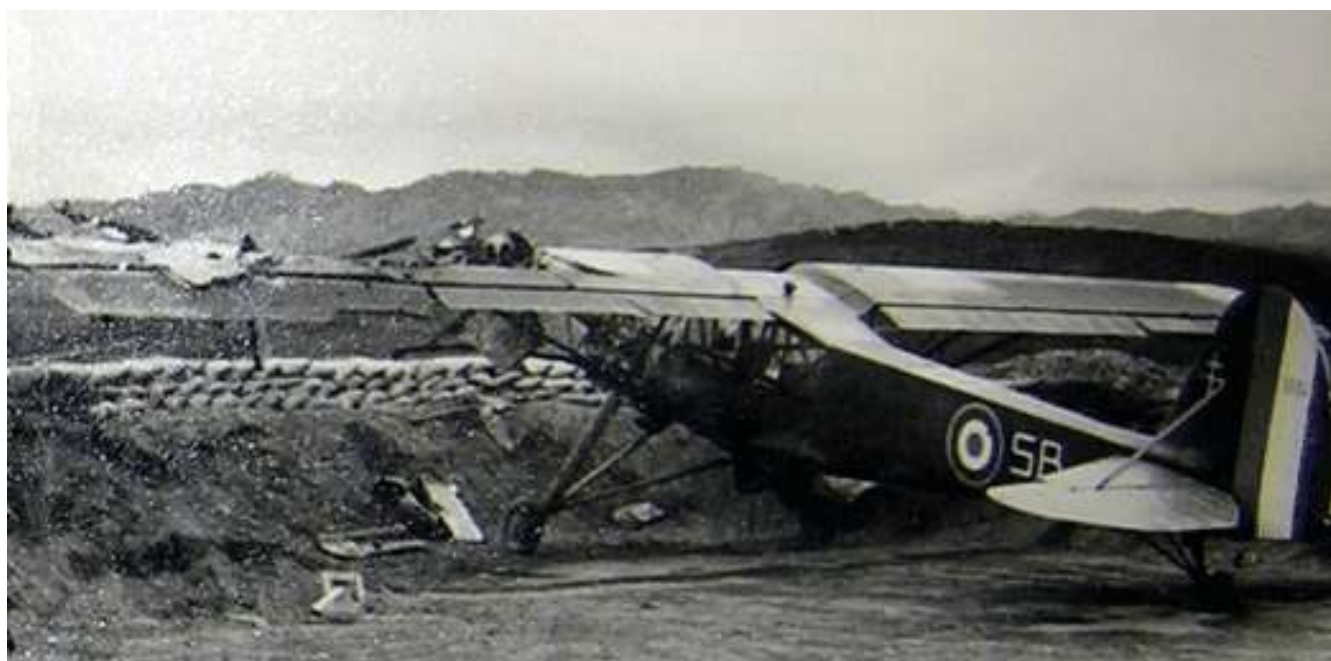
Morane 500 n° 796/SB du 21 e GAOA à Dien Bien Phu. Aile gauche détruite par l'artillerie Viet le 12 mars 1954. Appareil laissé sur place (photo Marcel Devaux, collection François Proisy).
